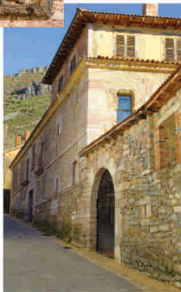
Casa de los Reyero
